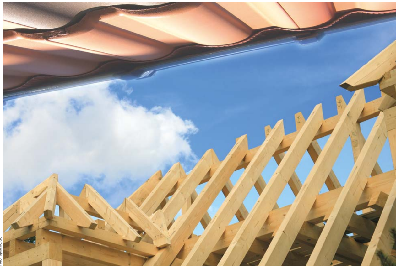
Negative Auswirkungen für Basel II für spekulative Bauträger
